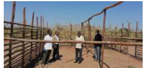
Baubeginn der Kirche.
