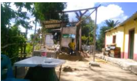
Hier entsteht die Werkstatt
